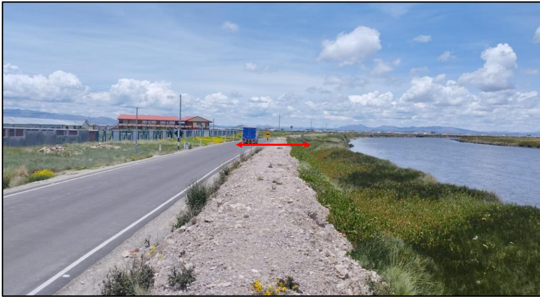
FIGURA N°02: CARRETERA Y CULTIVOS AGRICOLAS EXPUESTOS ANTE DESBORDE DEL RIO ILAVE A UNA CRECIDA EN LA MARGEN DERECHA, A LA FECHA EL ANCHO DEL DIQUE SE ENCUENTRA A 3
